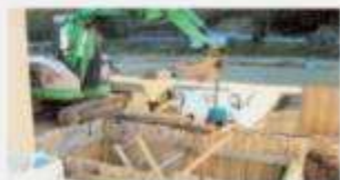
浄化槽設置工事
