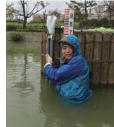
乙女が池スマート化工事
