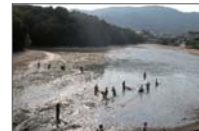
源蔵池 (9万トン貯留) 一池干し
